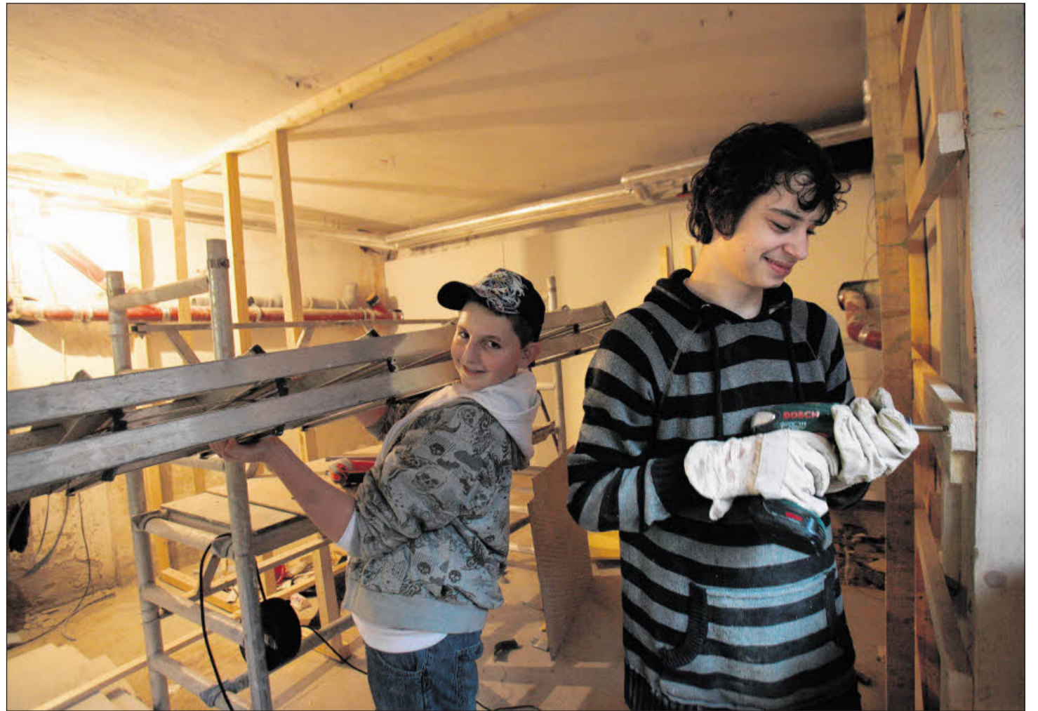
Das Team vom Bau: Wie ihre Mitschüler helfen auch Timo (rechts) und Steffen beim Umbau im Gebäude des Aufbauzweigs. Hier arbeiten sie gerade an der künftigen Werkstatt. ARCHIVFOTO: KAR-HEINZ BÄRTL
